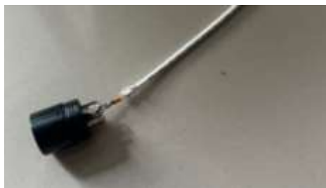
Gambar 16. Pembuatan Electrical Connector 1
