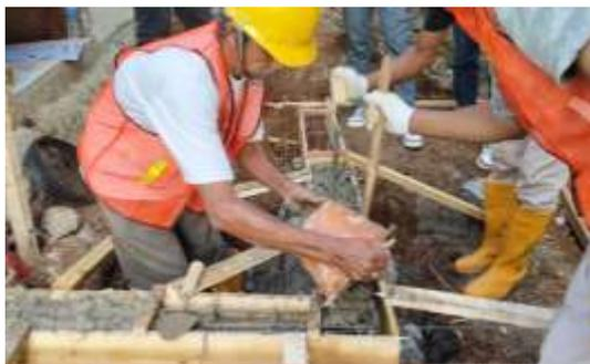
**Gambar 12:** Pekerjaan Pengecoran
