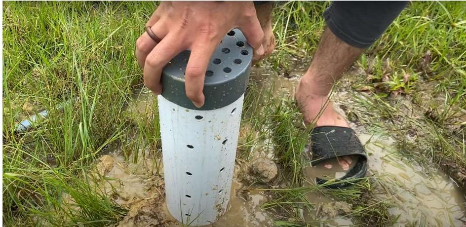
**Gambar 3. Pemasangan Tabung Biopori**
