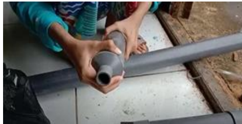
Gambar 3. Proses pemasangan sambungan pipa
