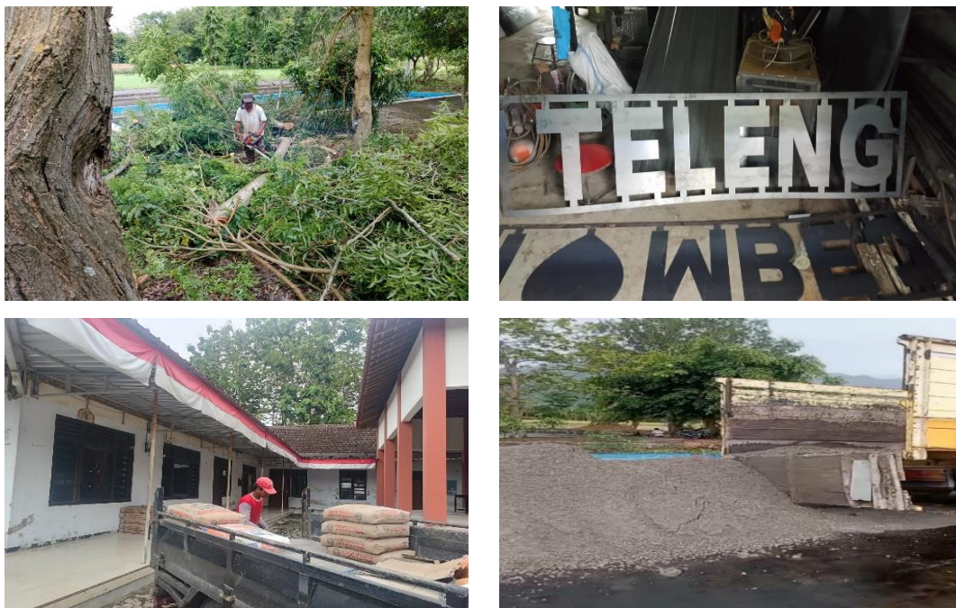
Gambar 5. Proses pembangunan atau penyediaan sarana pendukung
